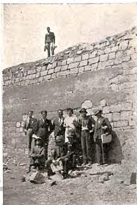
Paramento de piedras talladas, tipo cúbico, "isodomon", recubierto por un estuque de color rojo.
