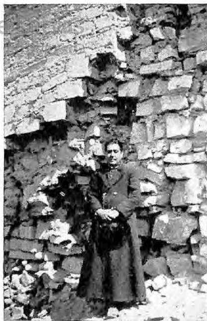
Sillería que muestra un aparejo irregular, "emplectonal".
